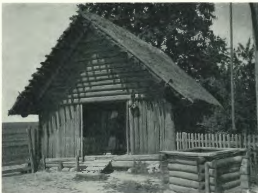
FIG. 1. HÄRBRE, »KLĒTS», UPPFÖRT I KNUTTIMRING OCH STAV- KONSTRUKTION. LATGALE
