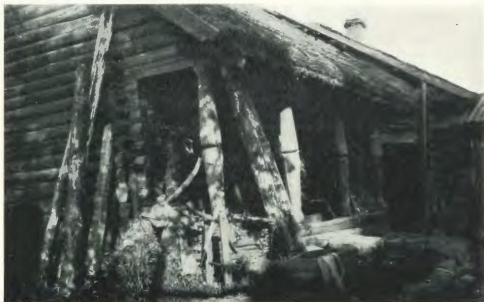
FIG. 2. HÄRBRE, »KLĒTS», UPPFÖRT I KNUTTIMRING OCH MED STOLPSTÖD I SVALEN. LATGALE
